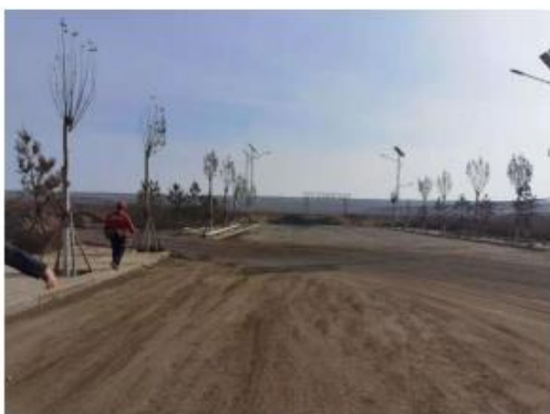
二期工程南部园区道路（东侧）
